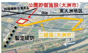
二線堤の保全・拡充 (鮎川水系、大洲市)
