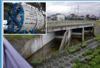
雨水幹線整備
