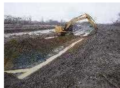
河道掘削 (石狩川水系、北海道開発局)
