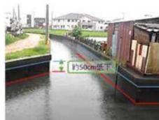
用水路の事前水位低下による雨水貯留 (吉井川水系、岡山市)
