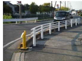
防護柵の設置
