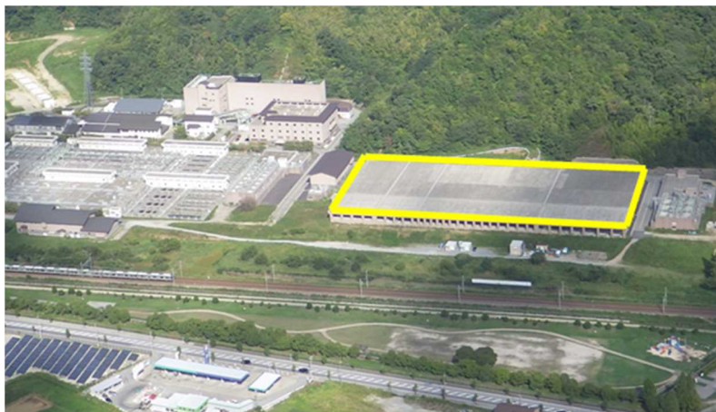
図 5-11 有効利用可能な空間の例（東北部浄化センター—覆蓋上部 約 13,000 m 2 ）
