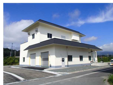
図 5-50 共同汚泥処理施設
