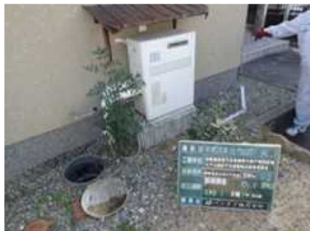
図 5-37 誤接続調査状況
