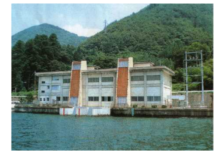
余呉湖補給揚水機場
