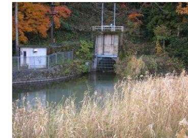
放水路トンネル
