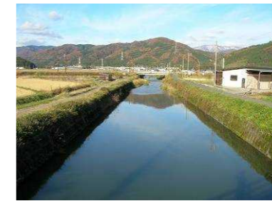
余呉川導水路
