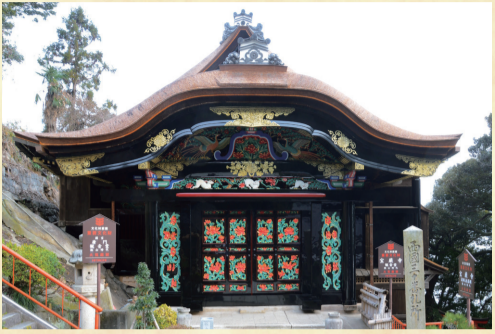
国宝 宝蔵寺唐門(桃山) 秀吉の築いた大坂城が竹生島に移築された遺構とされています。保存修理により、安土桃山時代の絢爛豪華な姿よみがえりました!
