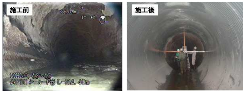
図 5-23 老朽化した下水道管の更生
