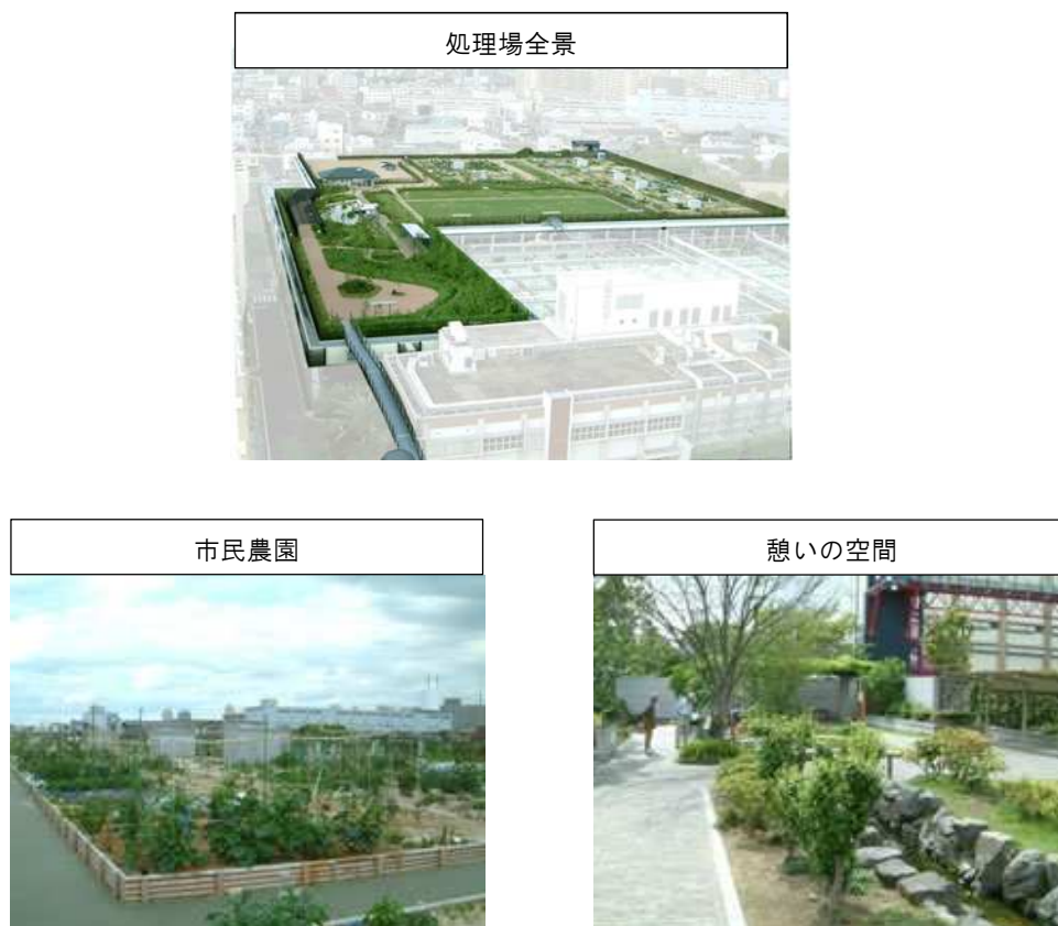
図 5-12 大阪市放出下水処理場写真
