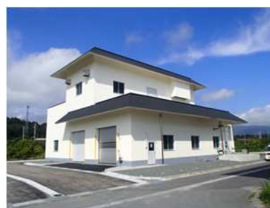
図 5-50 共同汚泥処理施設
