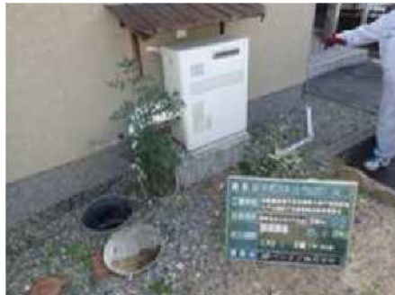
図 5-37 誤接続調査状況
