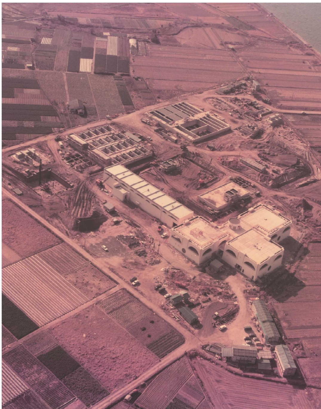
吉川浄水場 当初建設中
