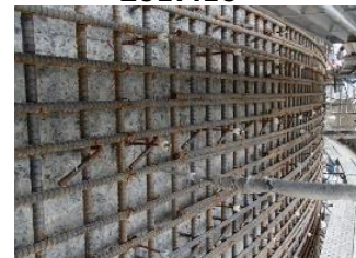
<外部遮蔽壁の補強> 2017.10~
