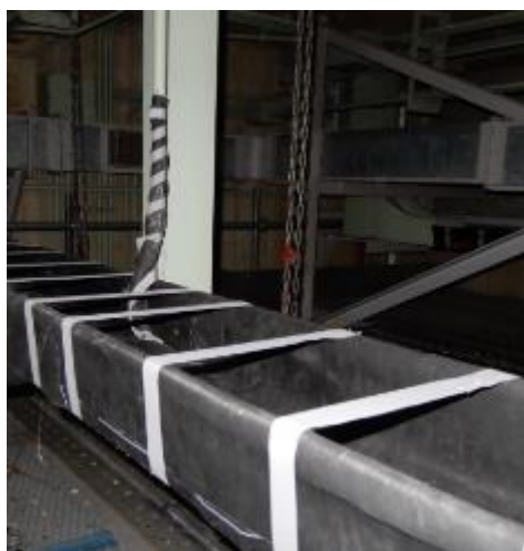
<防火シート施工箇所>
