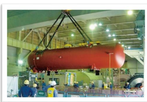
高圧給水加熱器の取替え
