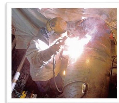
配管の取替え
