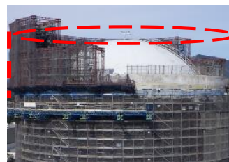
<外部遮蔽壁頂部の撤去> 2017.7~
