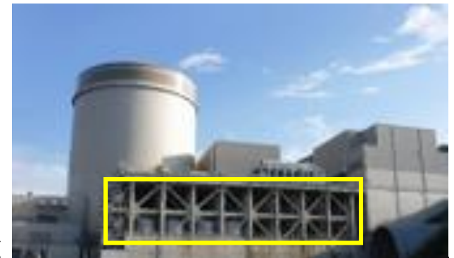
新構台の構築(現況)
