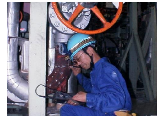
配管の厚み点検
