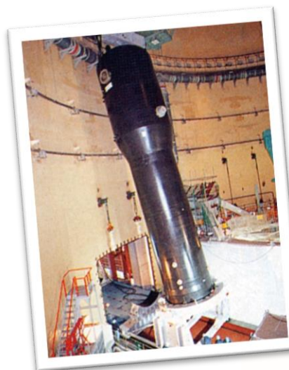
蒸気発生器の取替え
