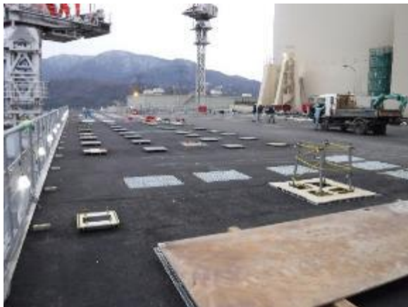
新構台の上部（現状）
