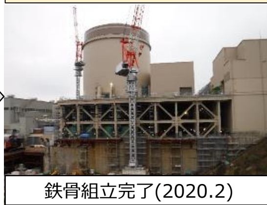
構台の設置状況
