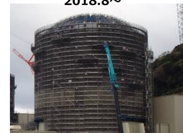
<上部鉄骨の組立> 2018.8~
