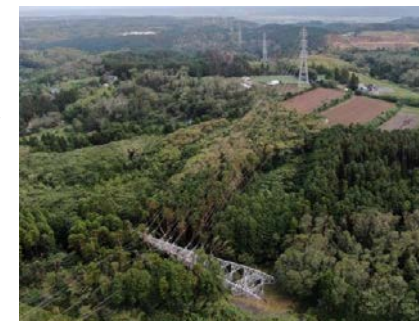
鉄塔設備の倒壊（君津市）
