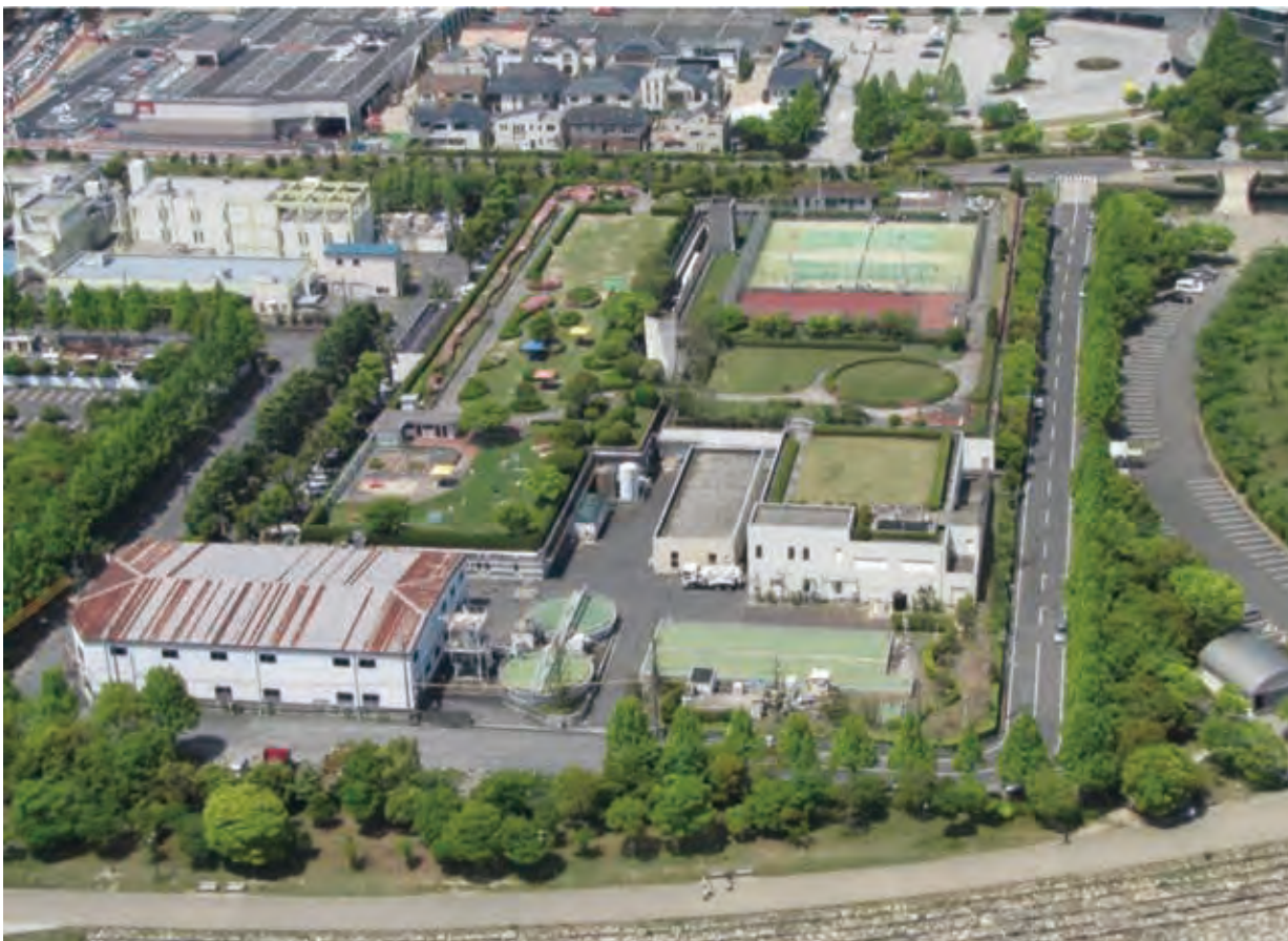
▲大津市水再生センター
