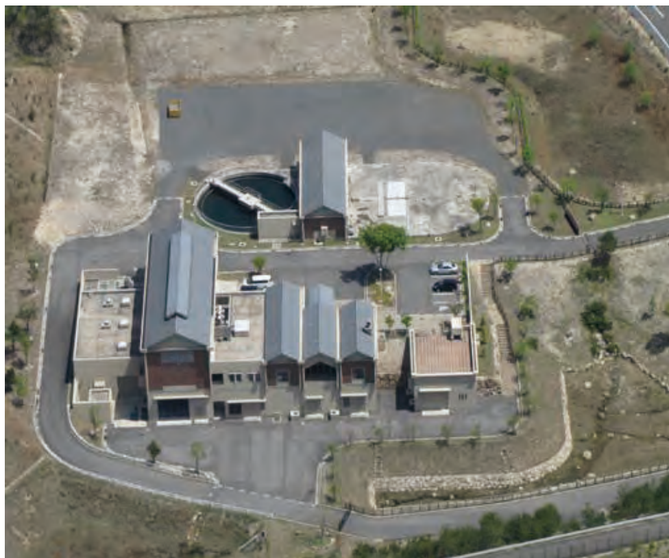
▲甲賀市信楽水再生センター
