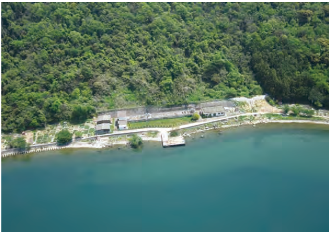
▲近江八幡市沖島浄化センター
