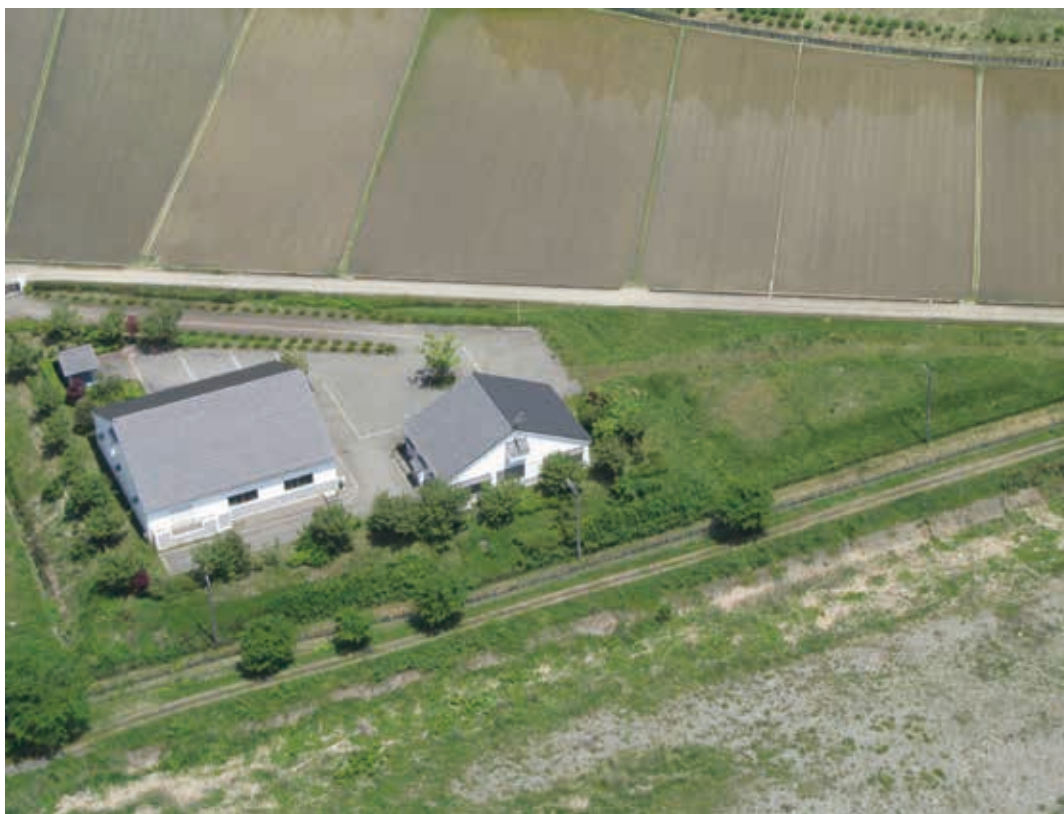
▲高島市朽木浄化センター
