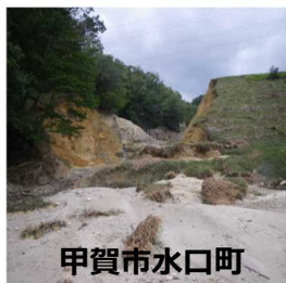
H29 台風21号 による被害
