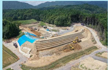
豪雨・地震対策として改修中のため池
