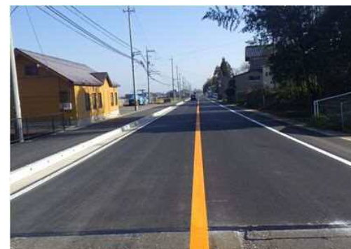
完成区間状況
