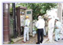
マンホールポンプ 停電対応訓練
