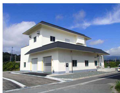
図 5-50 共同汚泥処理施設
