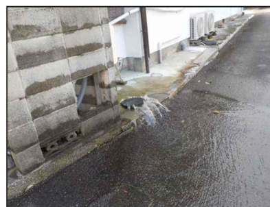
図 5-33 平成 29（2017）年台風 19 号 マンホール溢水状況
