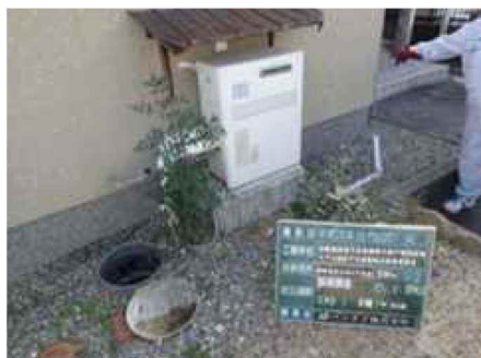
図 5-37 誤接続調査状況
