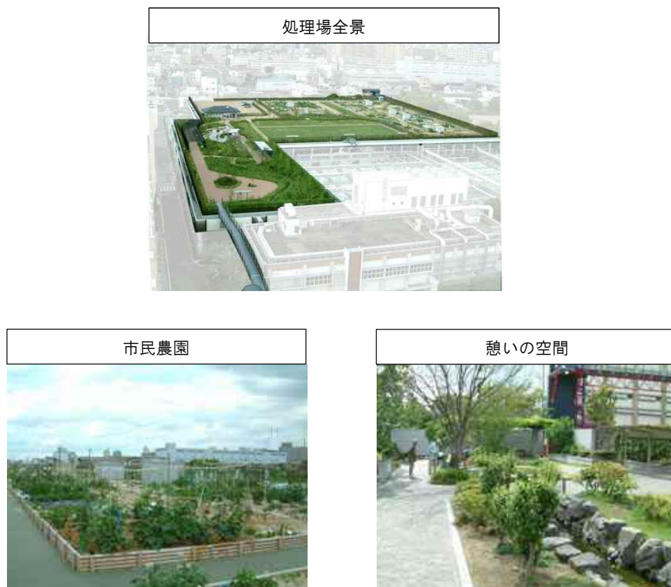
図 5-12 大阪市放出下水処理場写真
