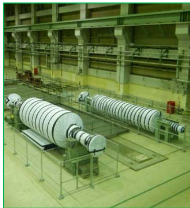
○タービン・発電機等解体工事の工事完了後の状況
