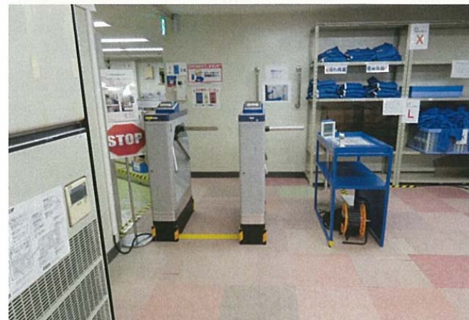
携帯確認装置設置状況（1号機サービス建屋）
