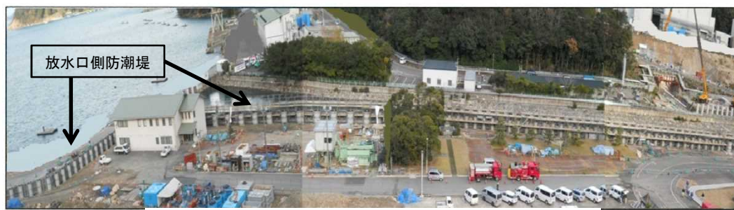
放水口側防潮堤
