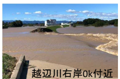
越辺川右岸0k付近
