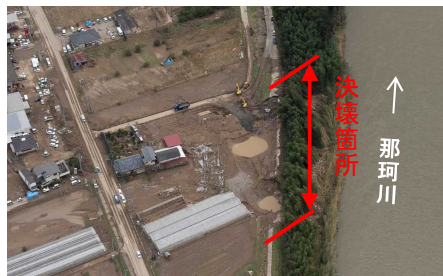
写真③ 堤防決壊状況（那珂川左岸40.0k）
