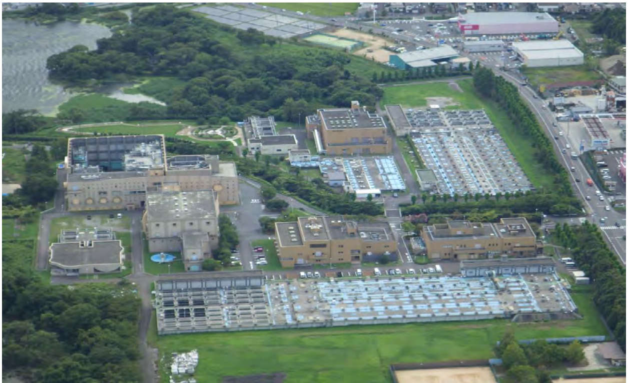
▲湖西浄化センター（大津市）
