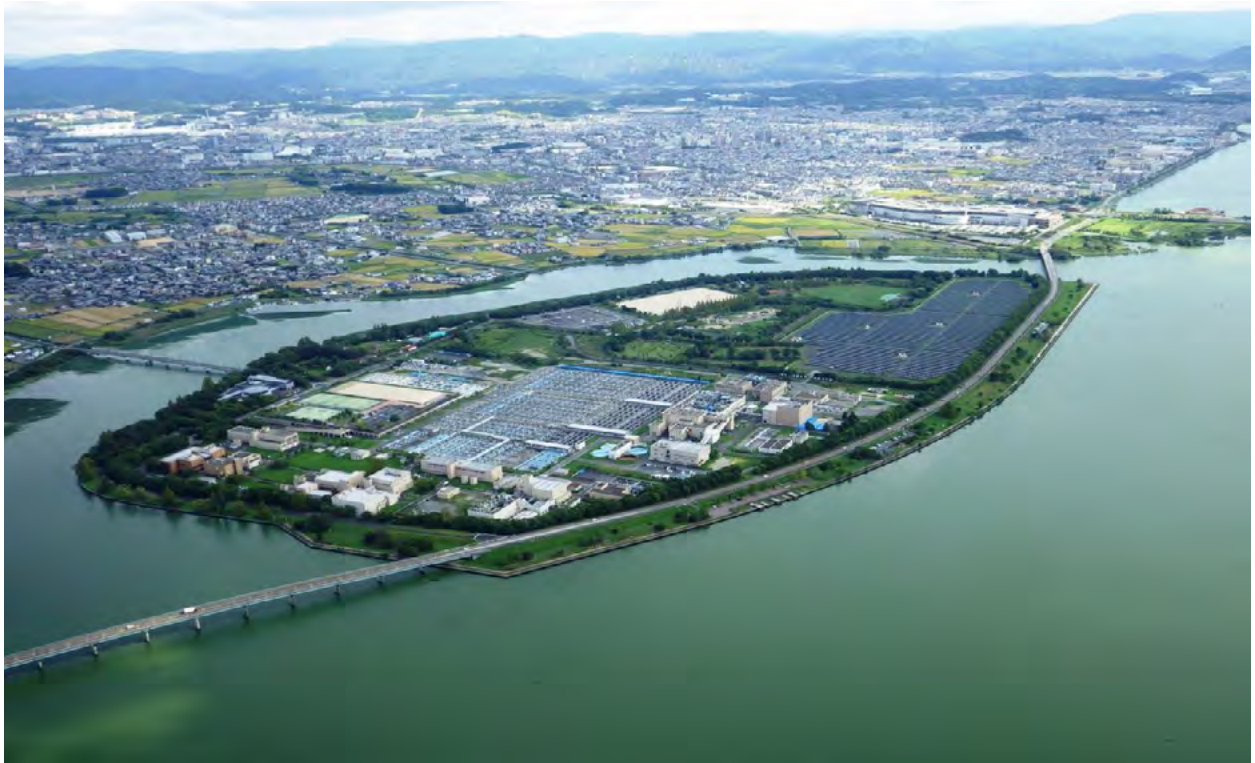
▲湖南中部浄化センター（草津市）
