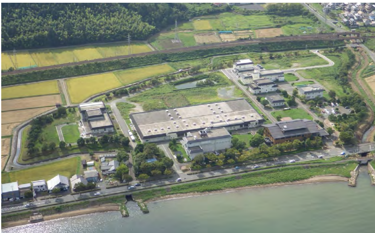
▲高島浄化センター（高島市）
