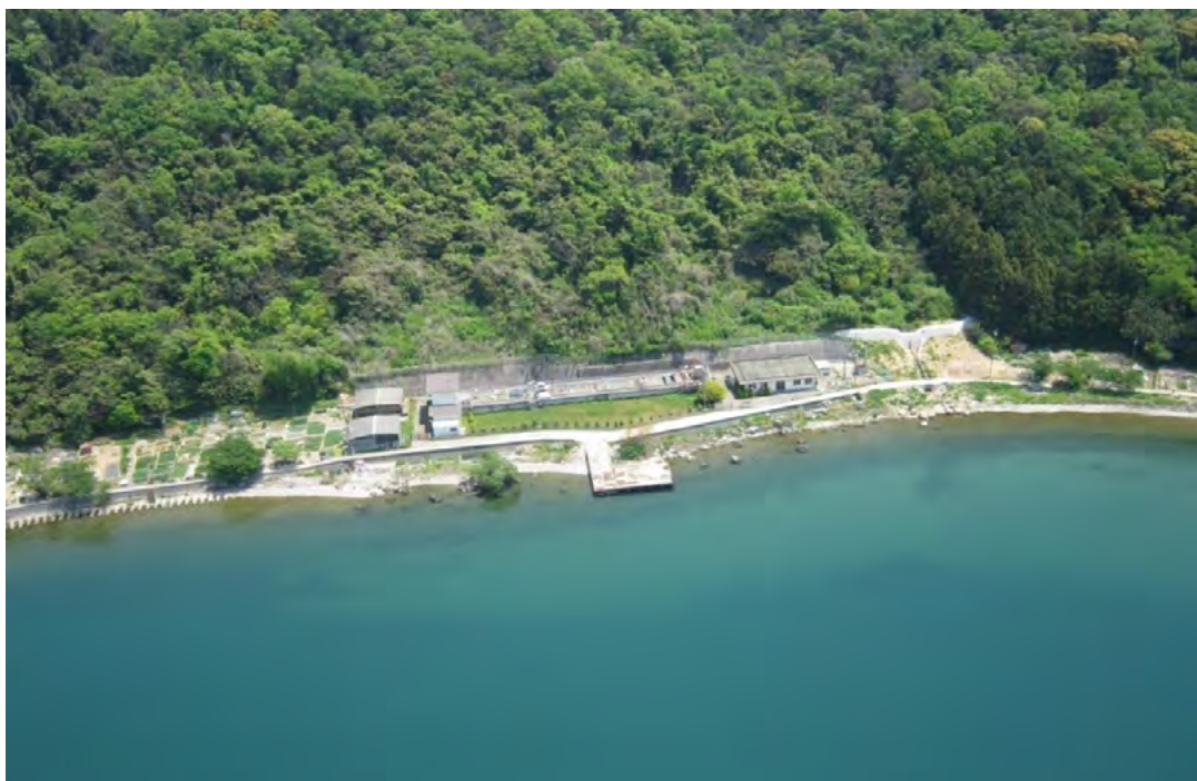
▲近江八幡市沖島浄化センター
