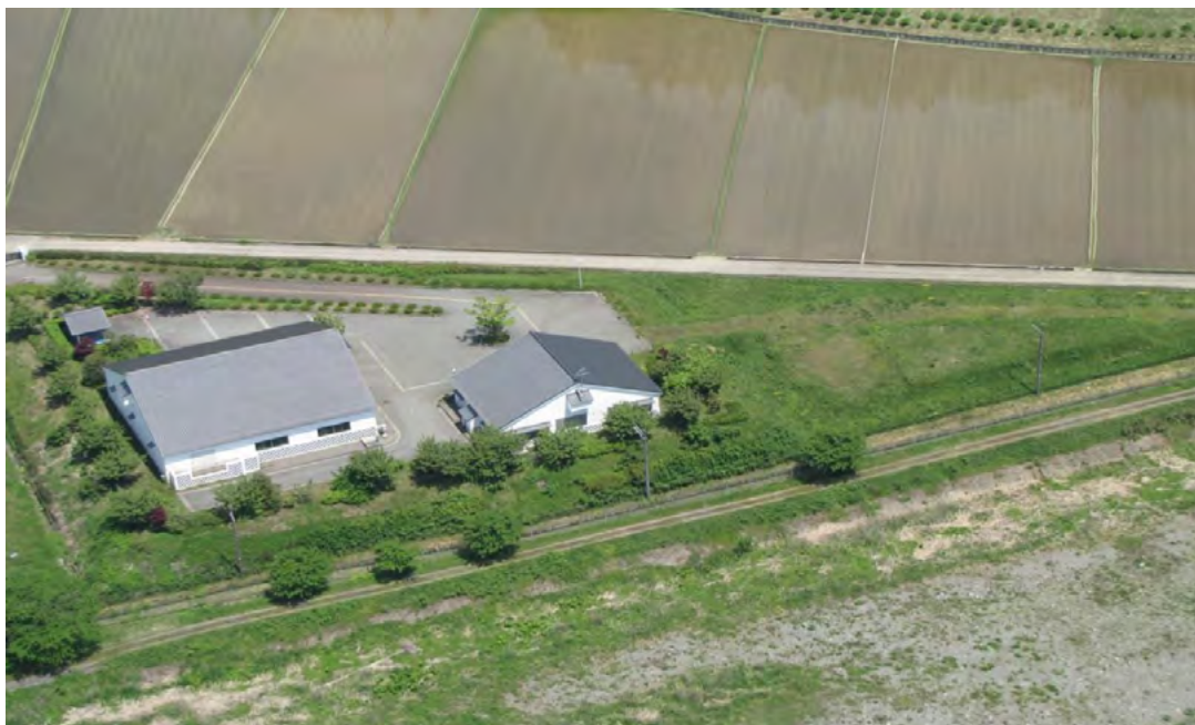
▲高島市朽木浄化センター
