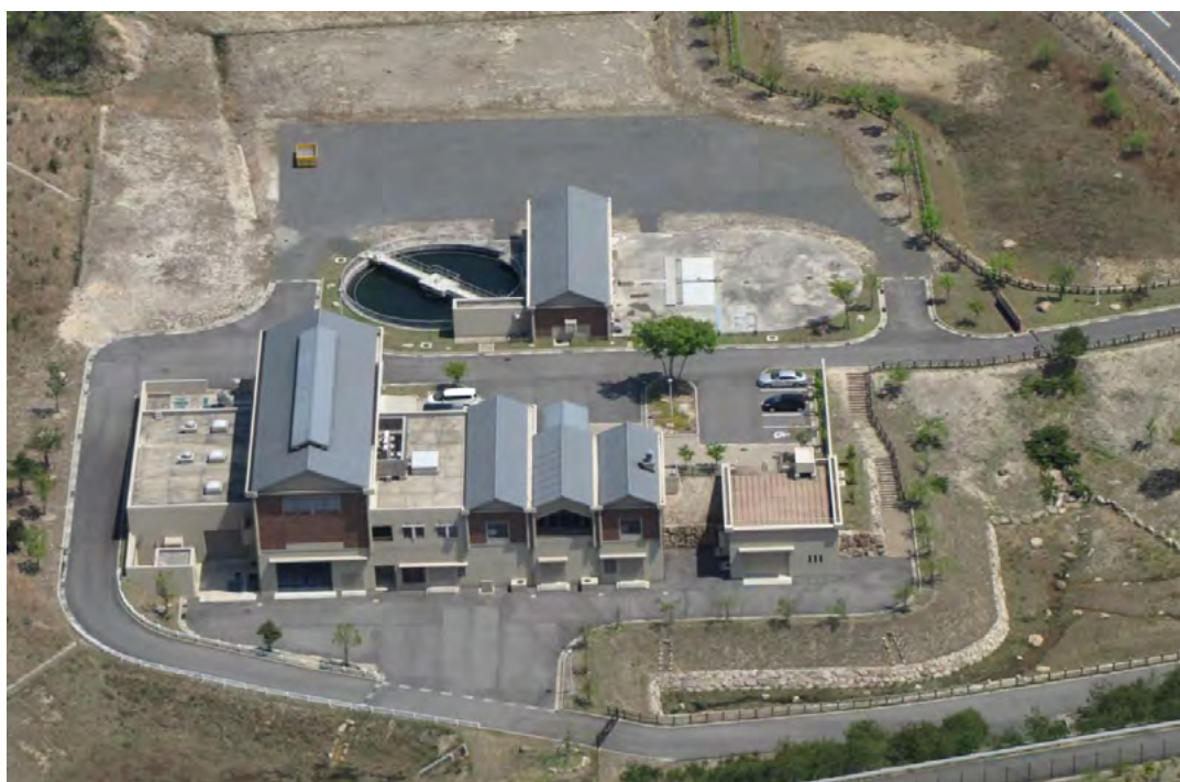
▲甲賀市信楽水再生センター
