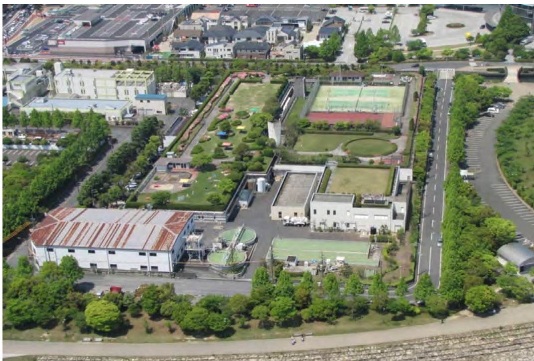
▲大津市水再生センター
