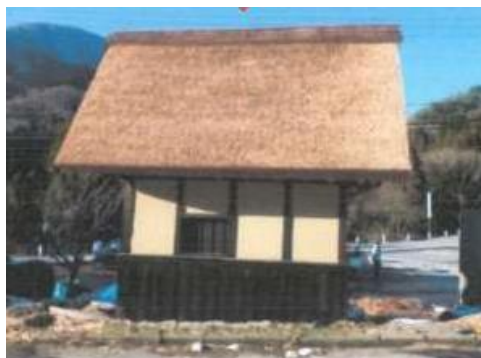
小屋屋根茅葺工事
