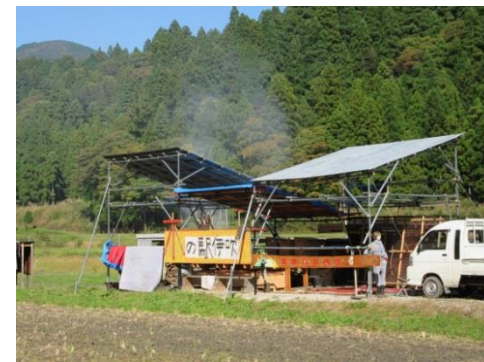
木の駅プロジェクト拠点屋根
