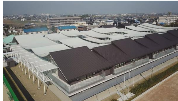
湖陸風を採り入れる屋根形状 7月20日 12時の太陽高度
