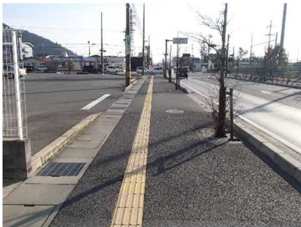
官民境界部に構造物を設置した事例(東近江市)
