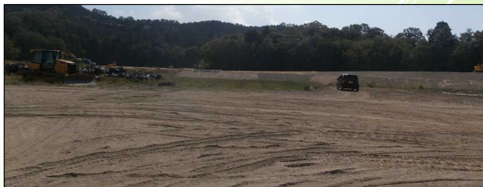
対象事業実施区域の現状 (令和元年10月1日撮影)
