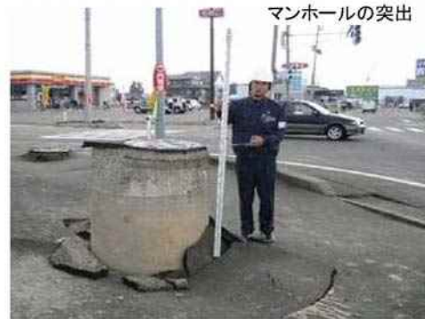
図 3-2-27. 新潟県中越地震における下水道施設の被害の状況
