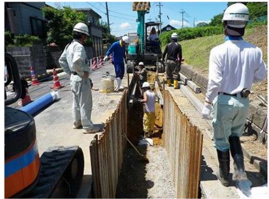
図 3-1-9. 下水管の布設状況
