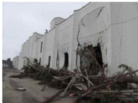
図 3-2-27. 新潟県中越地震における下水道施設の被害の状況
