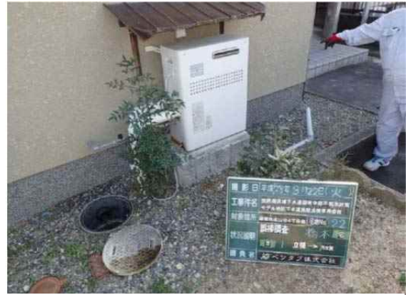
図 3-2-17. 不明水発生箇所の調査状況
