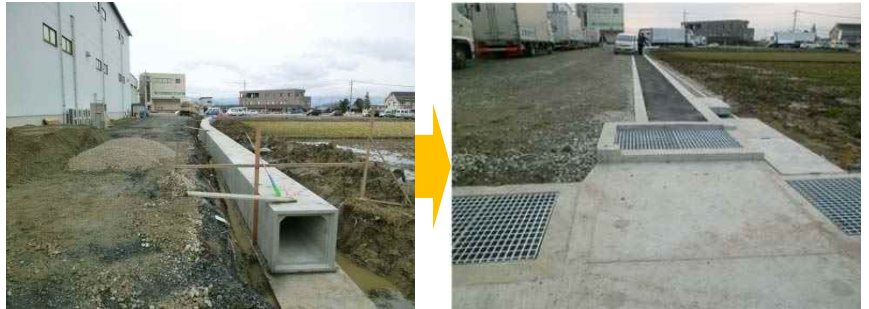
図 3-2-7. 守山市雨水渠の整備（施工中、完了）
