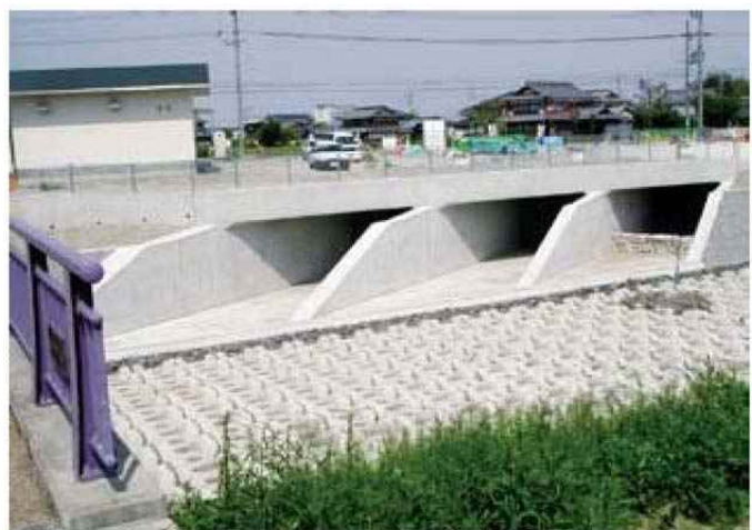
図 3-2-9. 守山栗東雨水幹線（新守山川放流部）
