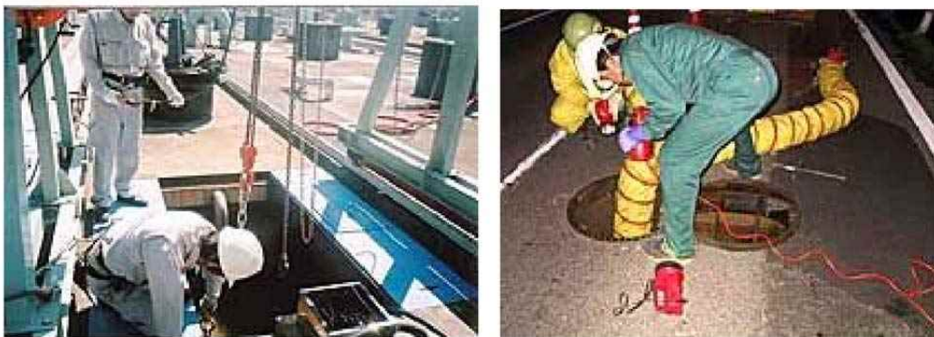
図 3-2-46. 処理場、管路の点検・調査状況
