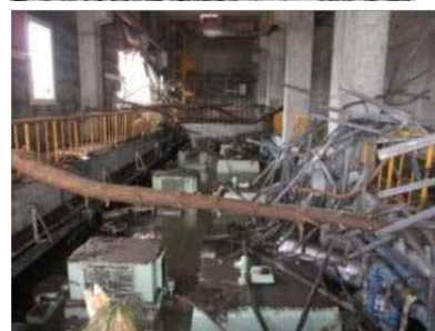
図 3-2-28. 東日本大震災における下水道施設の津波被害の状況
