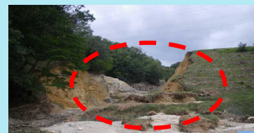
豪雨で破堤したため池
