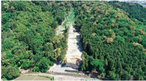
▲ 治山施設（山腹工）
