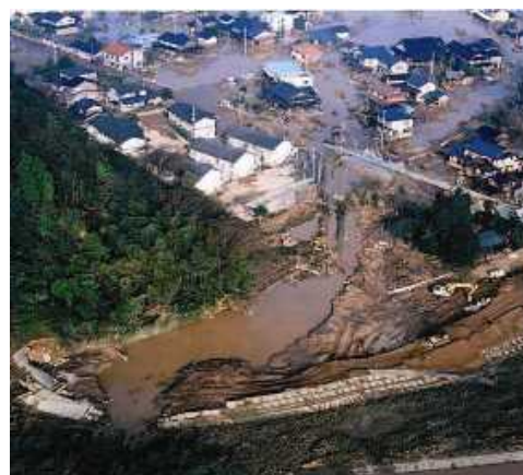
堤防決壊等に伴う氾濫流による家屋倒壊等
