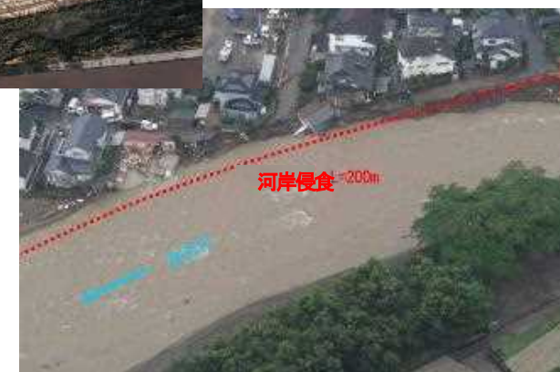
河岸侵食に伴う家屋倒壊等
