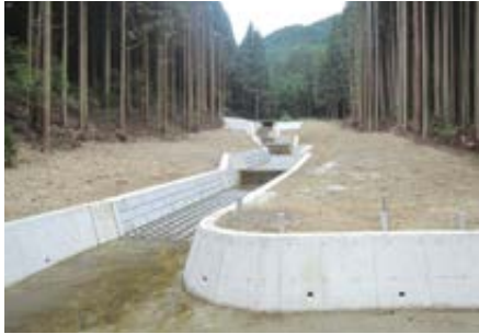
▲治山施設（流路工）
