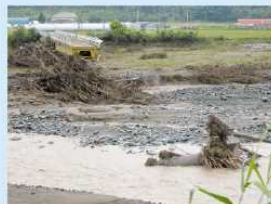
流木により流失した橋梁
