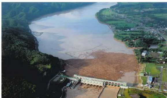
図 5-65 土砂流木の捕捉事例(1)
