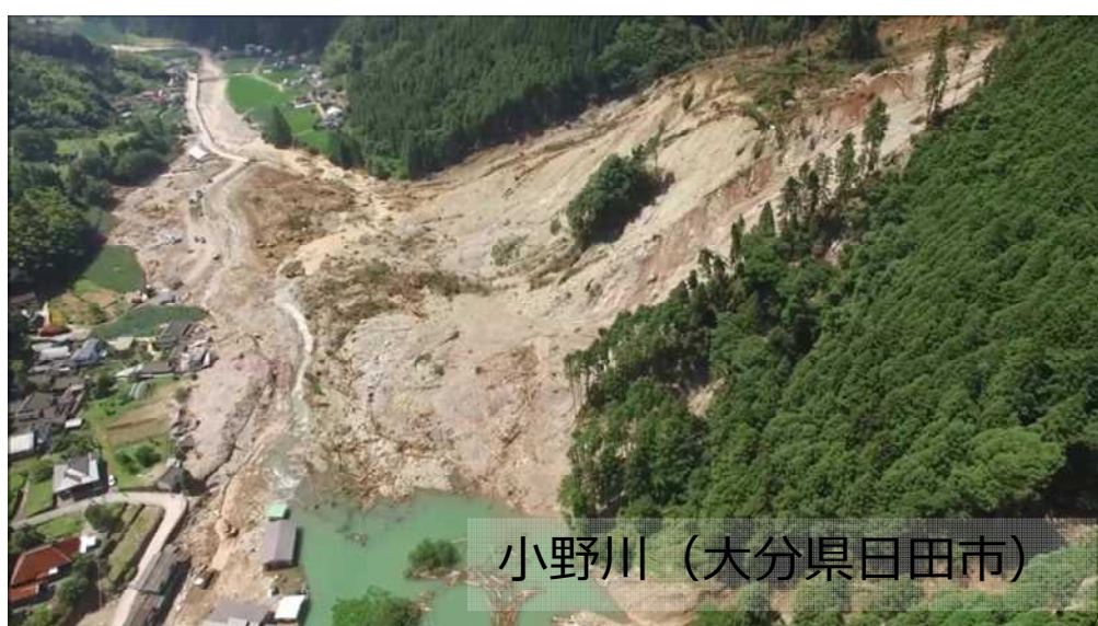
図 4-10 平成 29 年(2017 年)九州北部豪雨による被害状況
