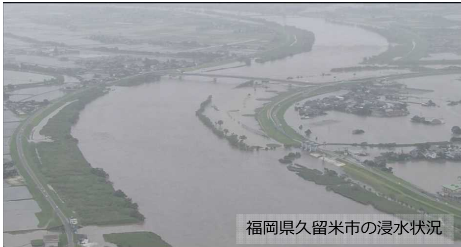
図 4-14 平成 30 年 (2018 年) 西日本豪雨による被害状況 (福岡県)
