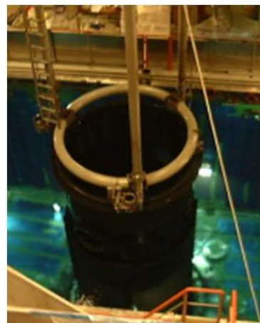
除染前の下部炉心構造物
