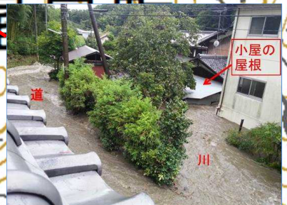
藤尾川が氾濫 小屋の屋根
