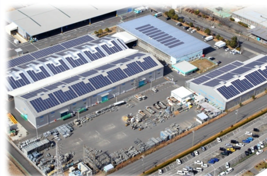
甲陸クリーンエネルギーセンター (写真: 甲西陸運(株)提供)
