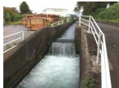
農業用水路における落差工
