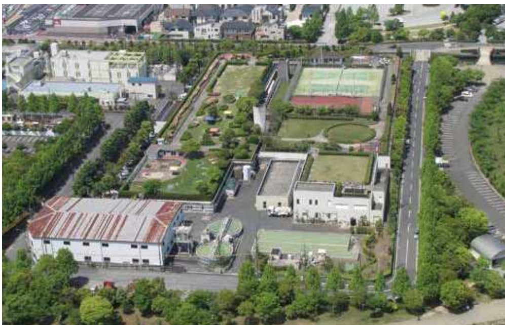
▲大津市水再生センター
