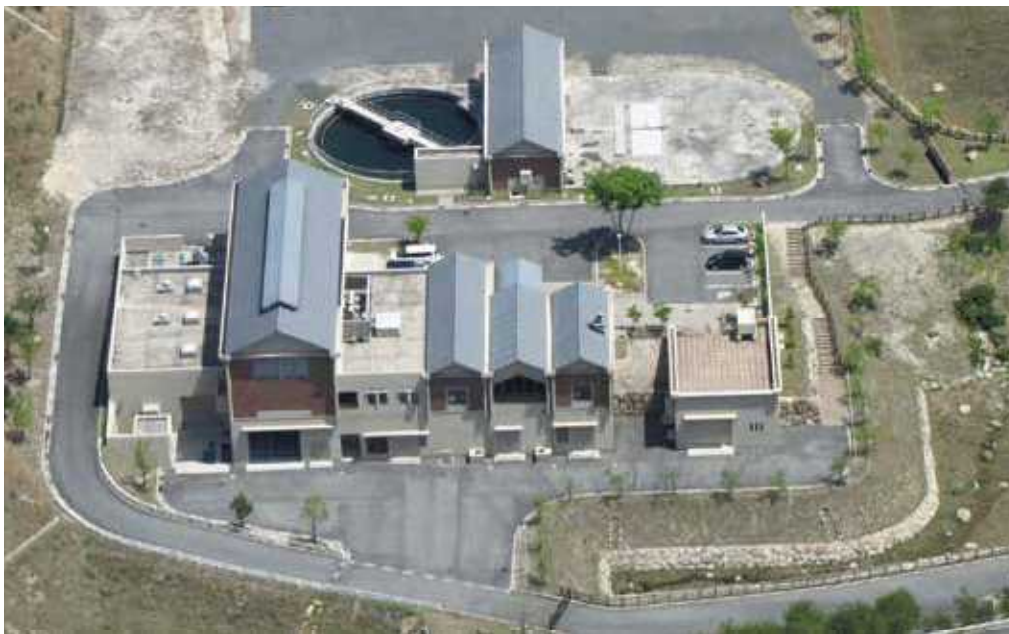
▲甲賀市信楽水再生センター
