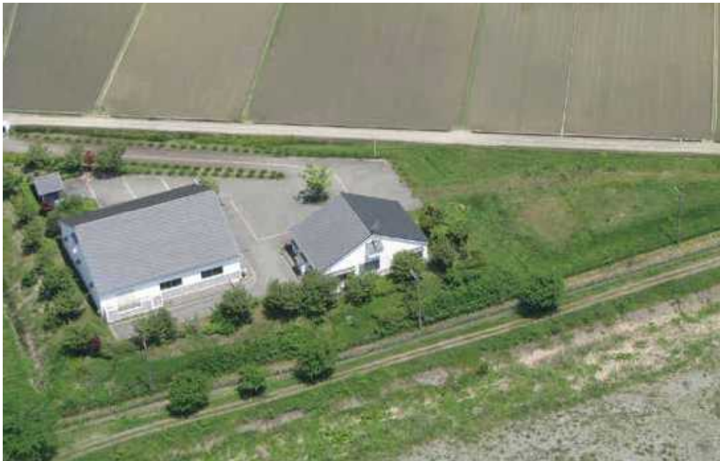
▲高島市朽木浄化センター
