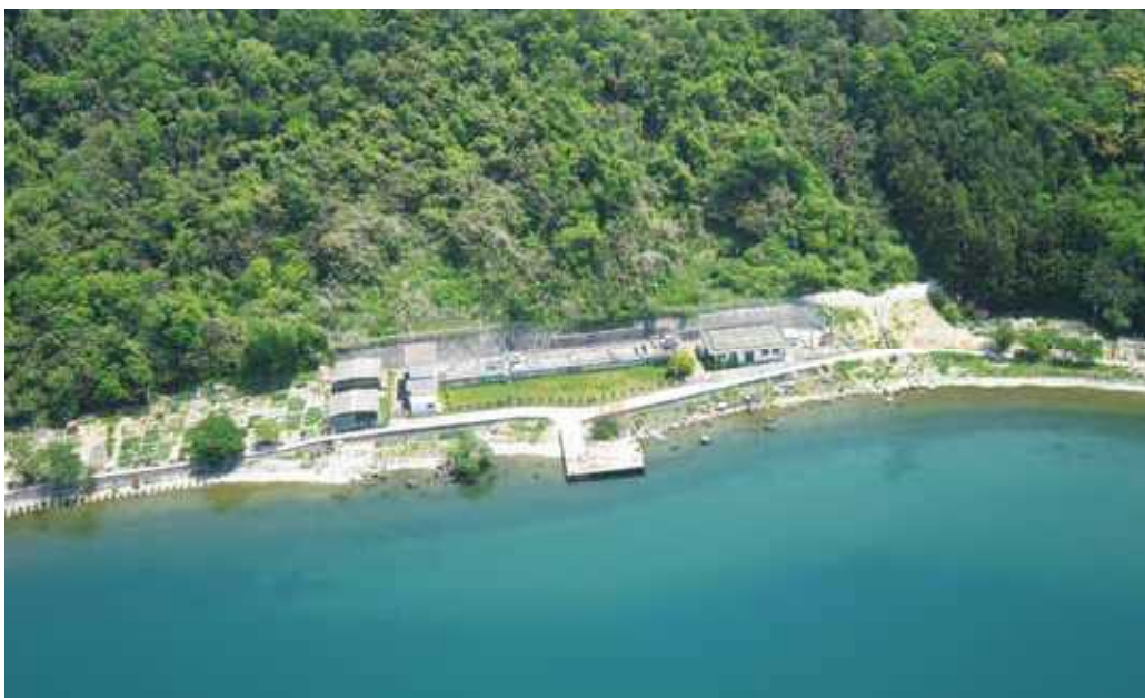
▲近江八幡市沖島浄化センター
