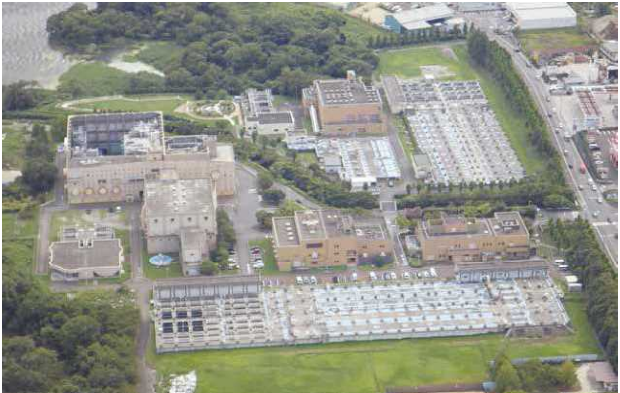
▲湖西浄化センター（大津市）
