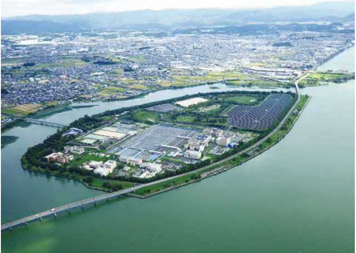
▲湖南中部浄化センター（草津市）
