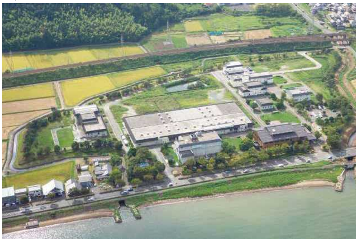
▲高島浄化センター（高島市）
