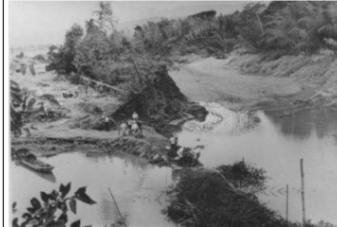
堤防決壊状況 （旧安曇川町二ツ矢地先）
