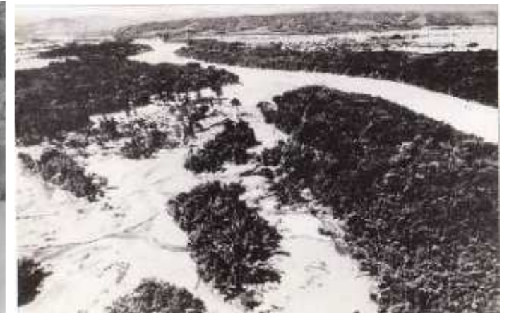
堤防決壊状況 （旧安曇川町川島地先）
