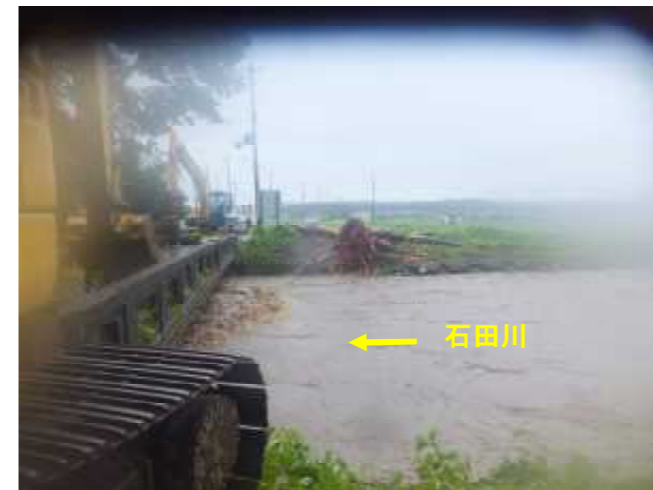
岸脇橋流下状況 （高島市今津町岸脇地先）
