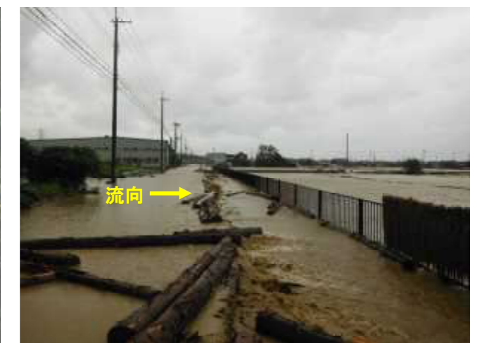
浸水被害状況 （高島市鴨地先）
