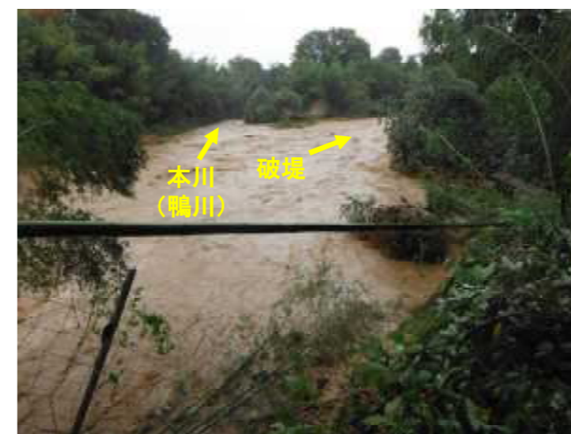
堤防決壊状況 （高島市宮野地先）
