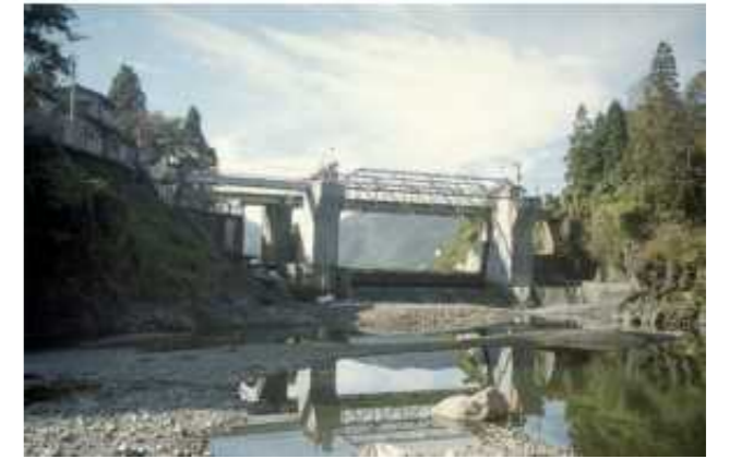
荒川発電所高岩頭首工(安曇川)
