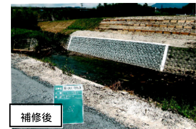
写真 護岸補修の状況（真野川）
