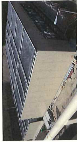
海水ポンプエリアの可燃物撤去後防火対策設置(設置後)
