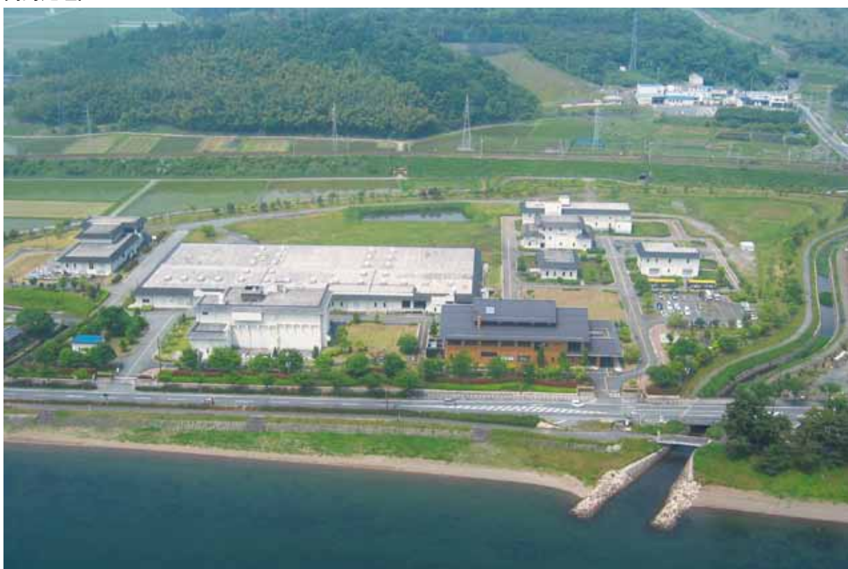
▲高島浄化センター（高島市）
