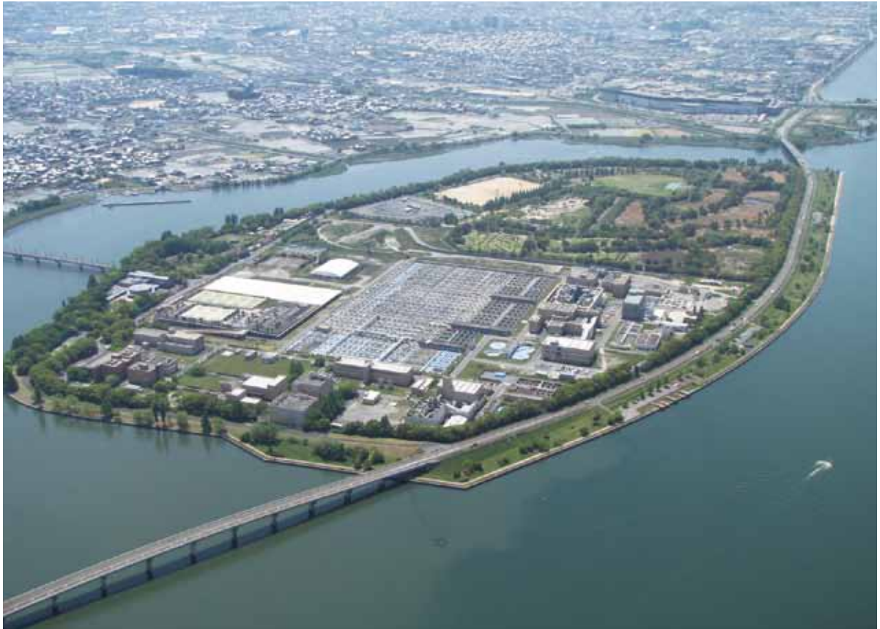
▲湖南中部浄化センター（草津市）
