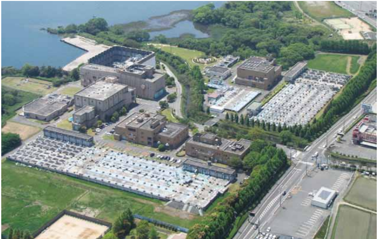
▲湖西浄化センター（大津市）
