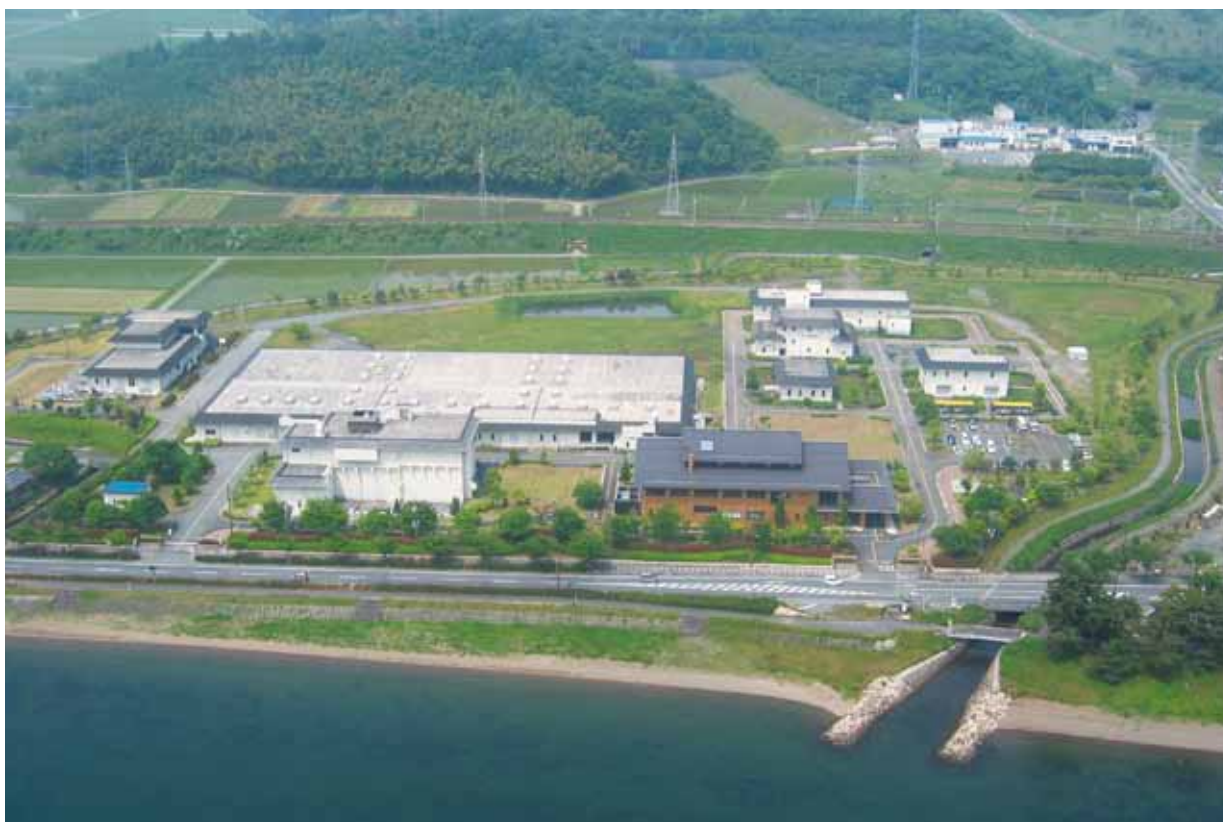
▲高島浄化センター
