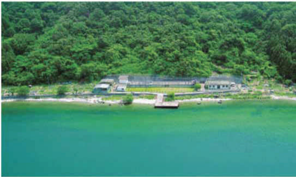
▲近江八幡市沖島浄化センター
