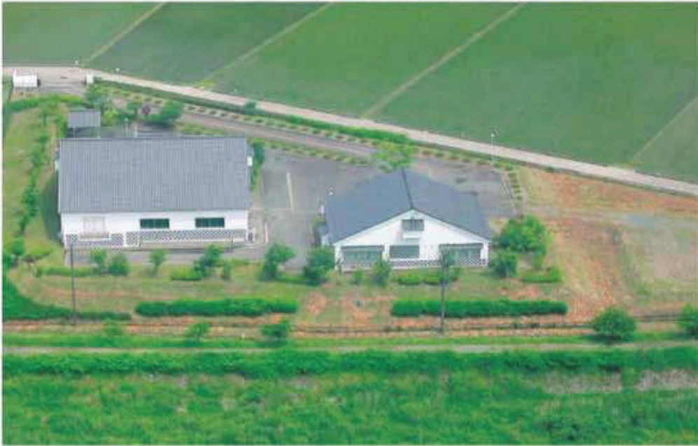
▲高島市朽木浄化センター
