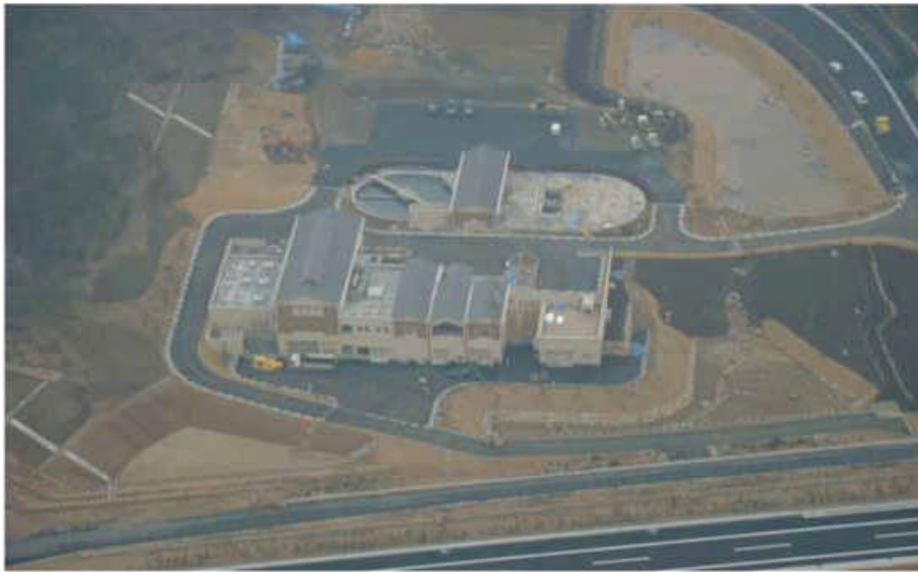
▲甲賀市信楽水再生センター
