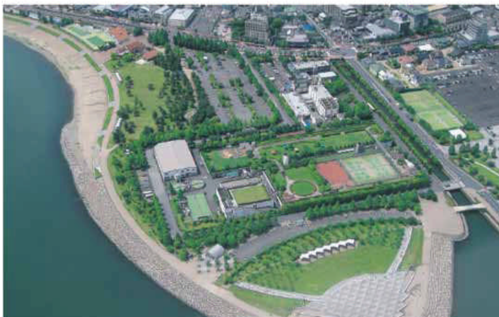
▲大津市水再生センター
