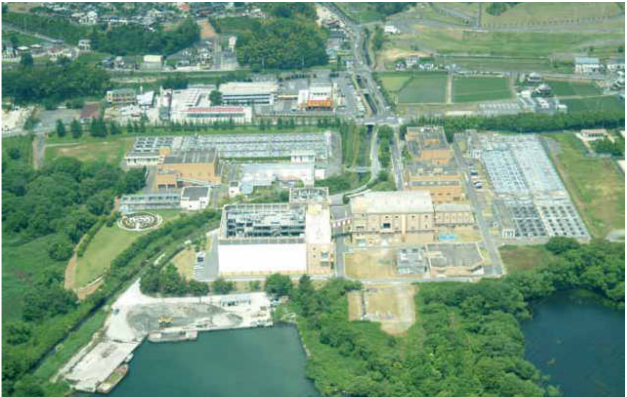
▲湖西浄化センター
