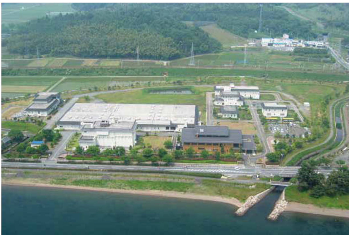
▲高島浄化センター
