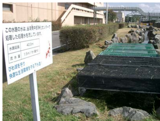
図 3-3-16. 下水処理水の再利用例 (湖南中部浄化センター)
