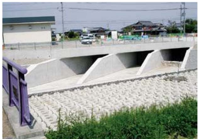
図 3-2-9. 守山栗東雨水幹線(新守山川放流部)
