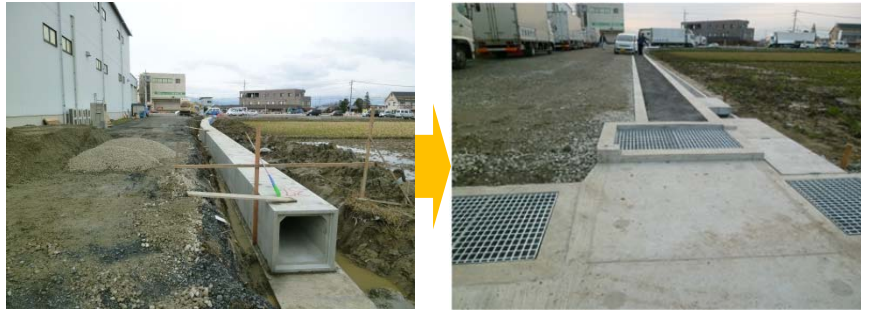
図 3-2-7. 守山市雨水渠の整備(施工中、完了)
