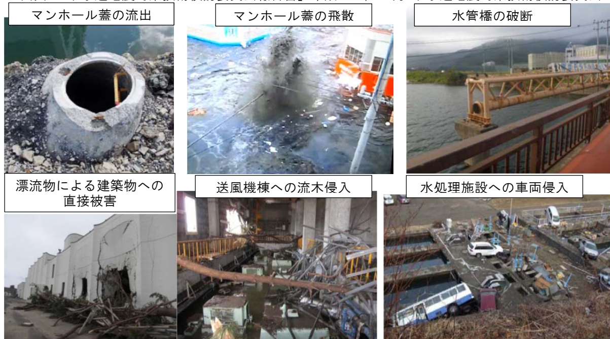
図 3-2-27. 東日本大震災における下水道施設の被害の状況
