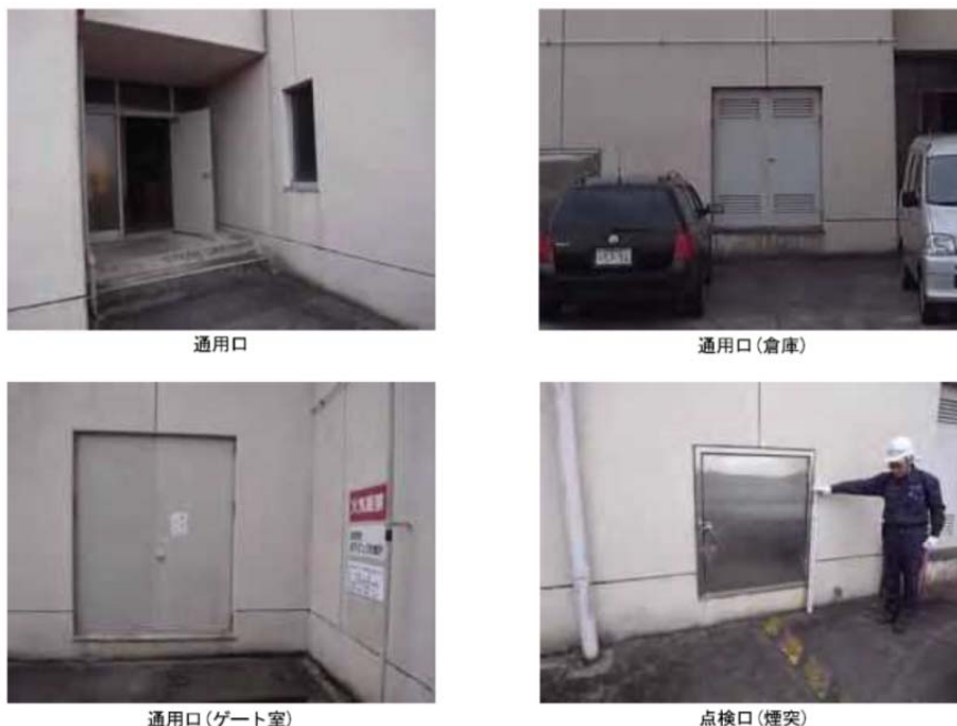
図 3-2-9. 守山ポンプ場における建屋開口等の調査状況
