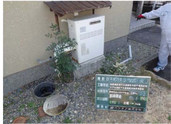
図 3-2-16. 誤接続箇所の調査状況
