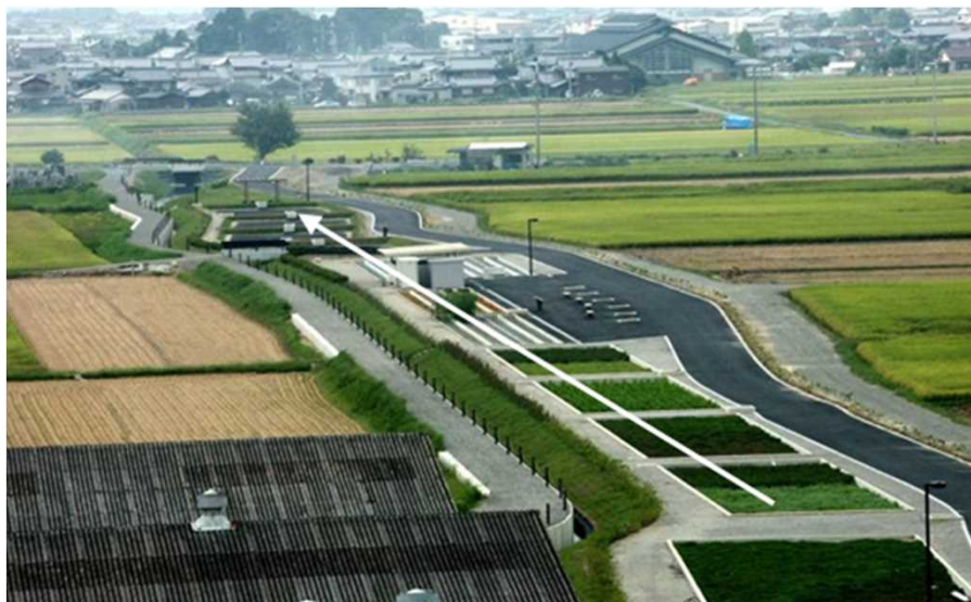
山寺川市街地排水浄化施設(伯母川ビオ・パーク) 住宅や道路など市街地からの排水を、 貯留・沈殿や植物・土壌等により浄化
